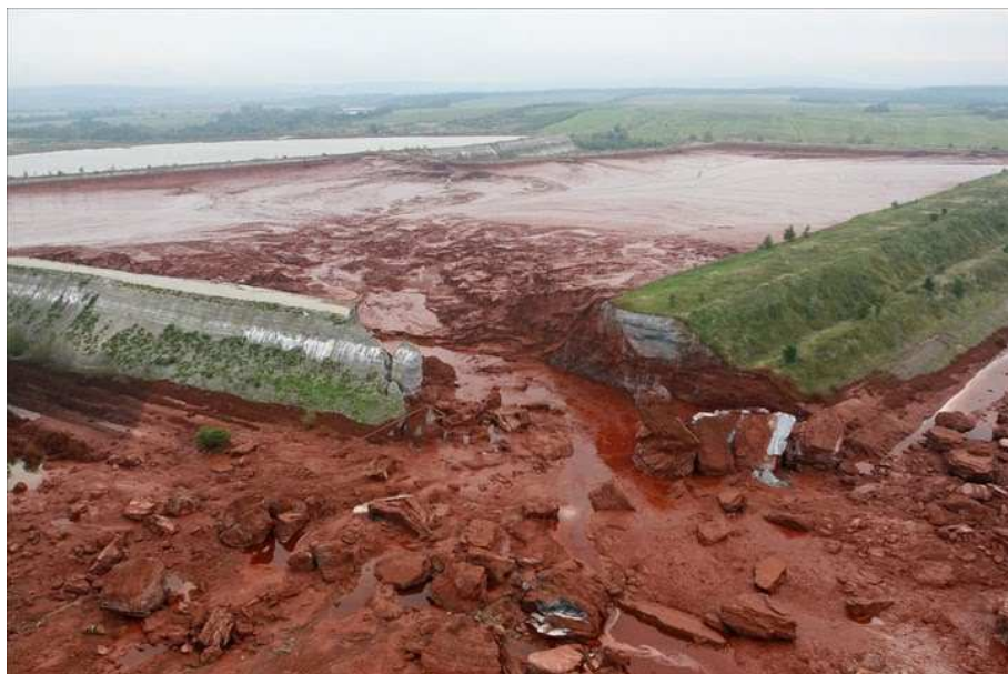
Obr. 5.2: Pretrhnutá hrádza na odkalisku červeného kalu v Maďarskej Ajke
