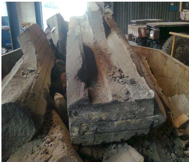
Obr. 5.15: Pohľad na búranie elektrolýznej vane
