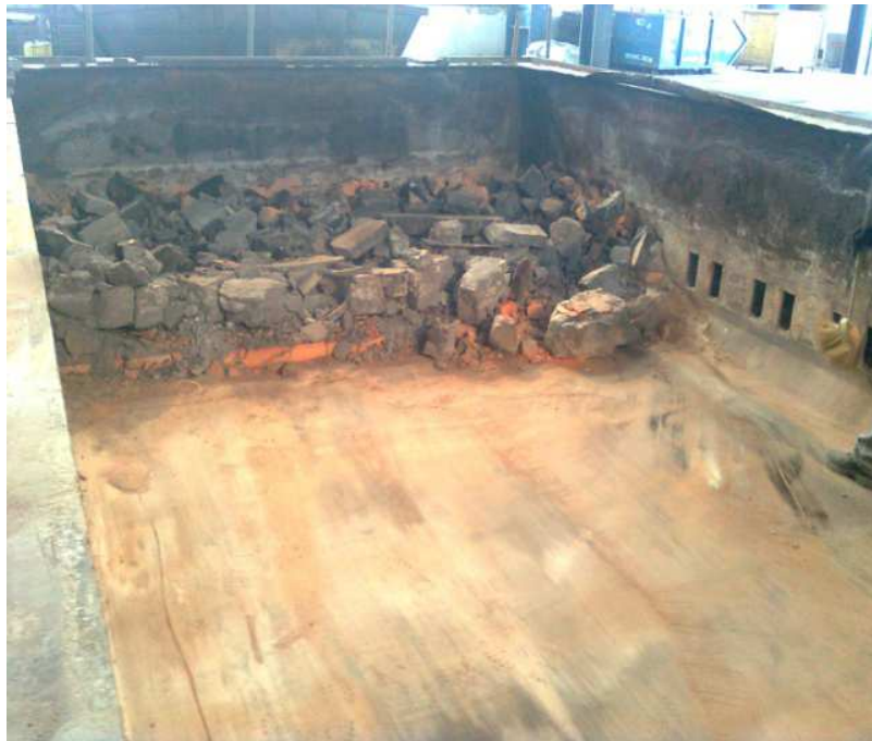
Obr. 5.14: Odpad vybúraných katódových blokov
