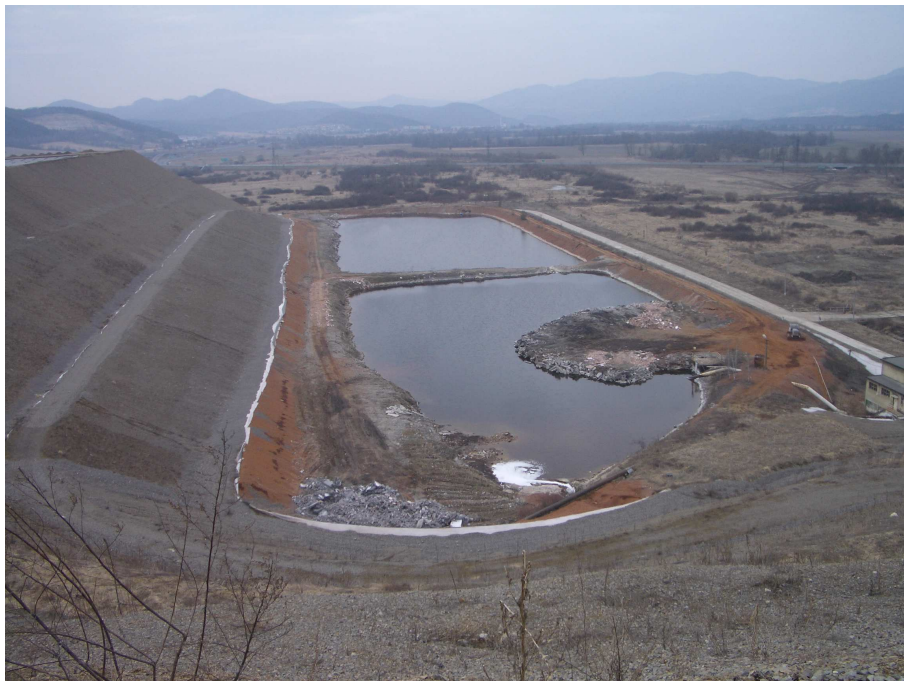
Obr. 5.6: Vzhľad Akumulačnej nádrže a haldy v priebehu sanácie
