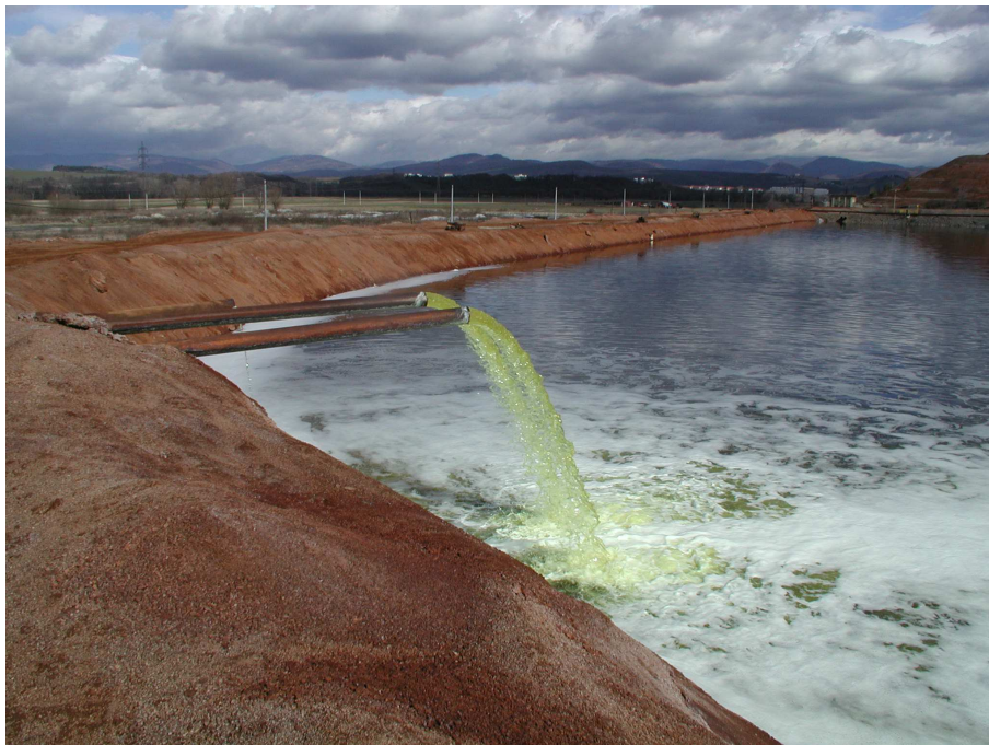
Obr. 5.4: Pohľad na odkalisko haldy červeného kalu v ZSNP žiar nad Hronom, minulosť. V popredí vidno prečerpávanie odpadovej vody, žlté sfarbenie reprezentuje prítomnosť chrómu
