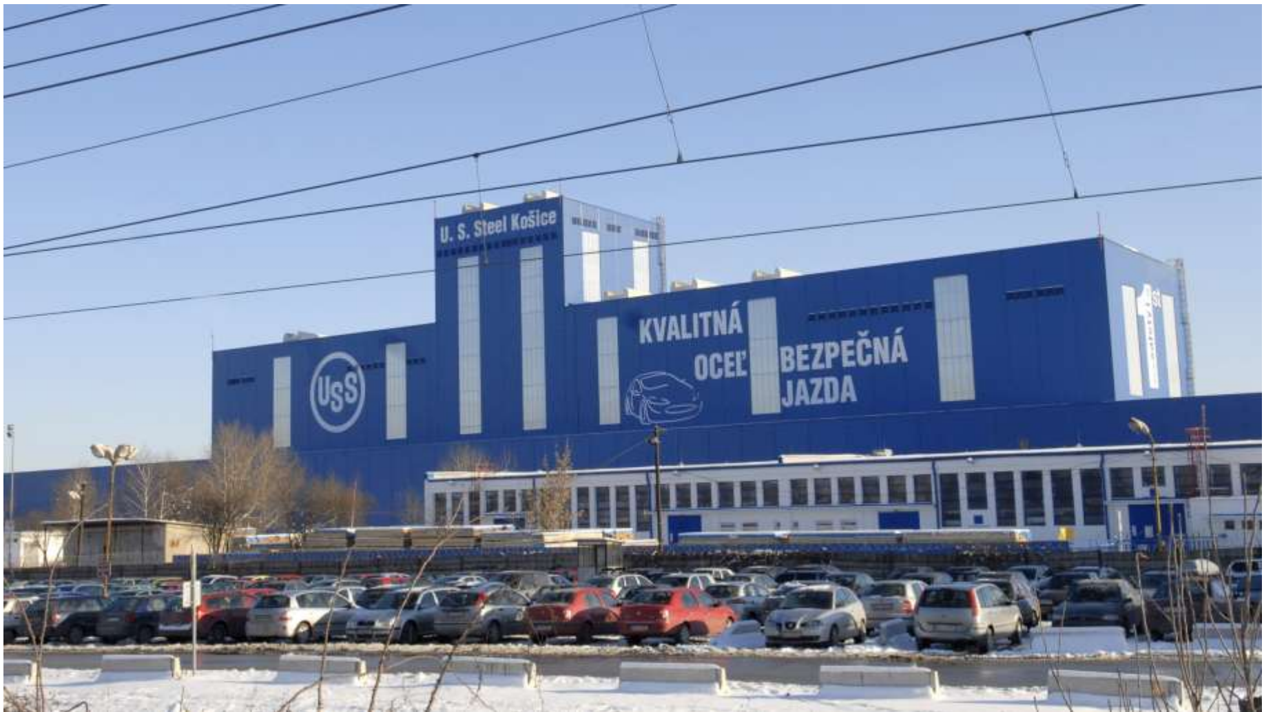
Budova s linkou pre kontinuálne zinkovanie
